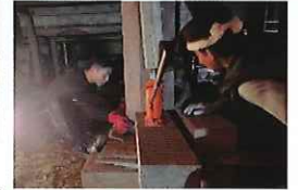
↑お寺の傾きをジャッキ で調整しています。
